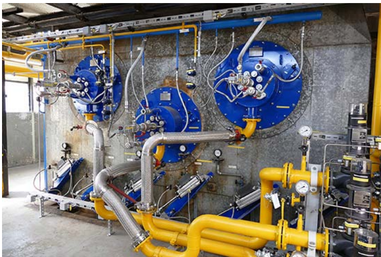
Seit Ende Juli fließt das Gas: Die neuen Gasanschlüsse an einem der Kessel im Zanders-Kraftwerk. Foto: Zanders
